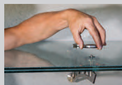
4/ Visser les caches supérieurs avec leur joint
