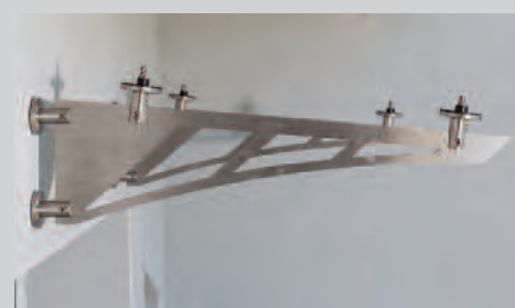
3 / Poser la console sur les fixations murales et monter les fixations supérieures à œillet avec leur joint
