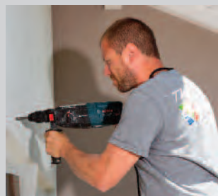
1 / Percer les trous et adapter la fixation en fonction du support
