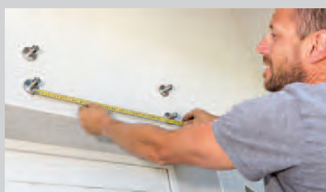
2 / Visser les fixations murales avec œillet sur la tige filetée
